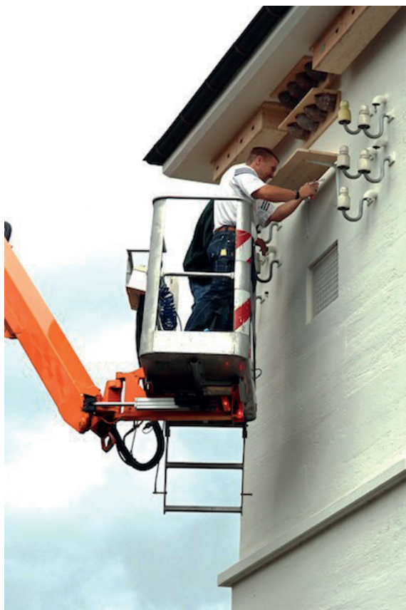
Letzte Montage eines Kotbretts für Mehlschwalben (Fotos: Esther Brunner)
